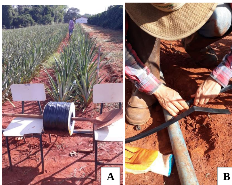
Figura 5 - (A) Distribuição das fitas gotejadoras entre as linhas de abacaxi; (B) Fitas gotejadoras na conexão inicial de linha
