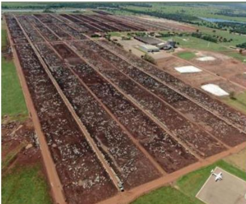
Figura 3 – Área destinada ao Confinamento Colorado. À direita tem-se o pátio de silos, fábrica de nutrição, galpões de insumos, oficina, refeitório.
