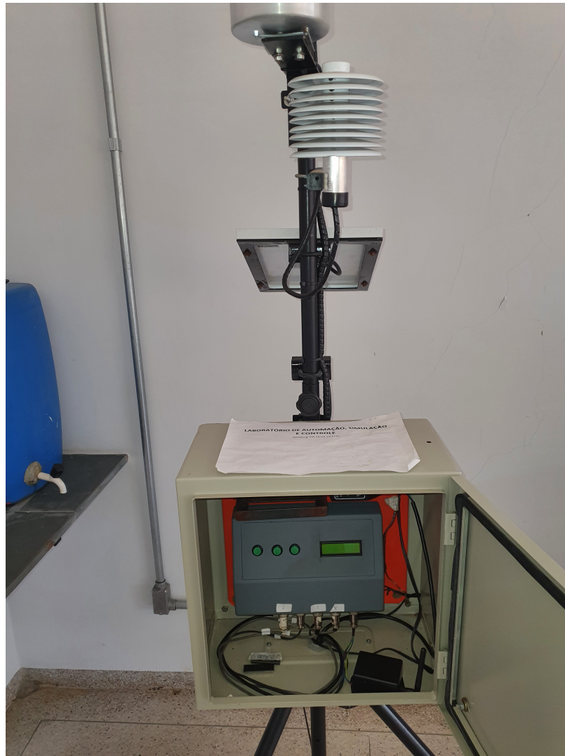
Figura 14 – Instalação do módulo transmissor
