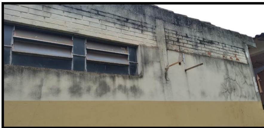
Figura 27: Manchas de mofo e fungos na varanda da ala oeste do bloco administrativo
