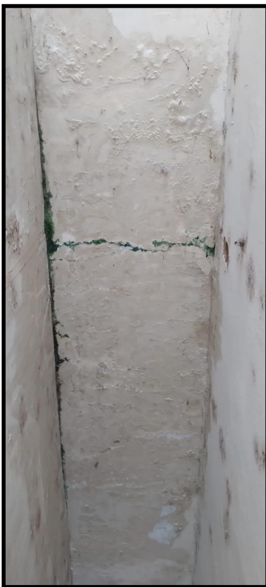
Figura 34: Saponificação e bolhas no teto da parte externa da secretaria de graduação de cursos superiores do bloco pedagógico I
