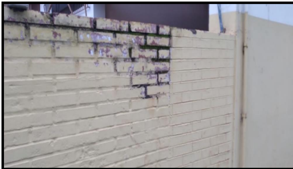
Figura 25: Manchas de mofo e fungos na varanda da ala oeste do bloco administrativo
