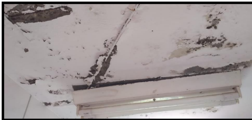
Figura 9: Armadura exposta oxidada na passarela na ala norte do bloco administrativo
