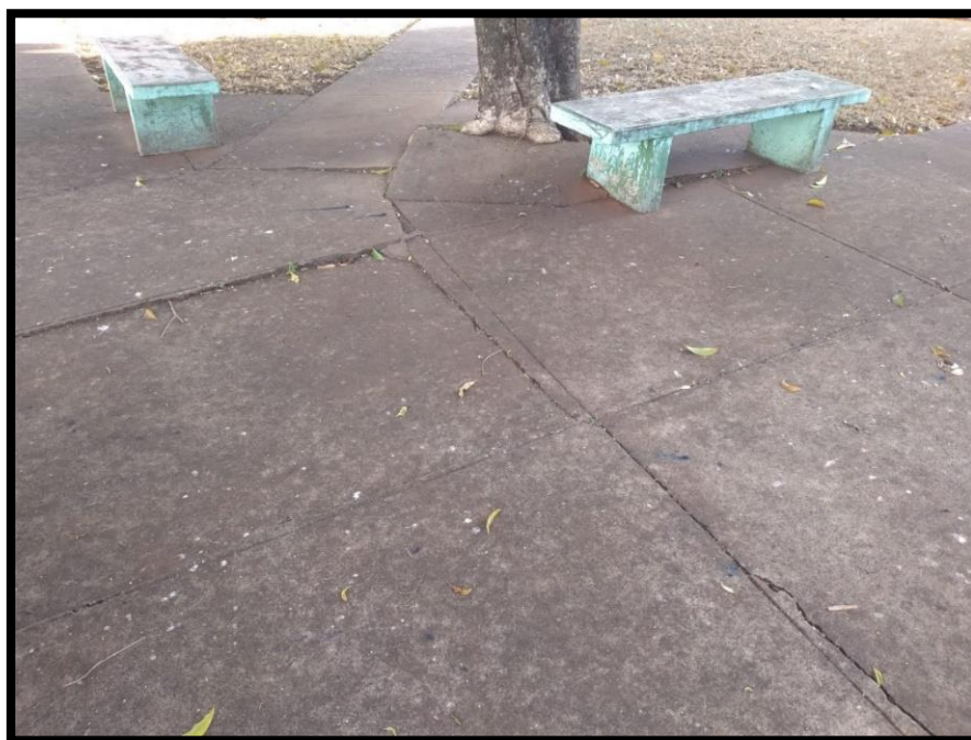
Figura 63: Presença de árvore no pátio do bloco administrativo
