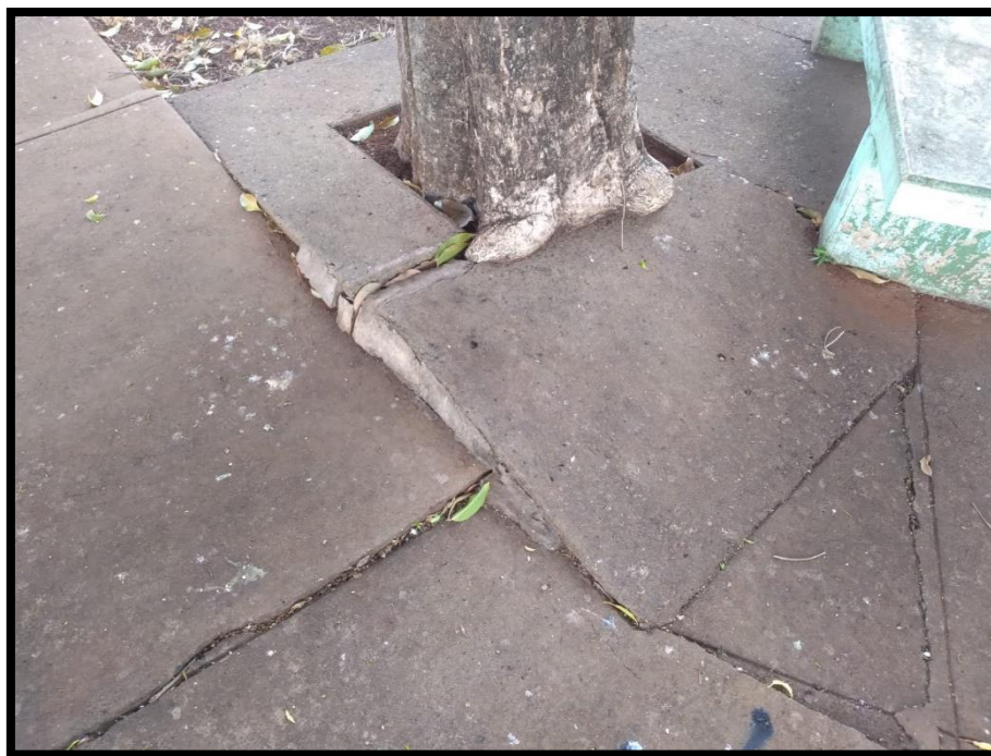
Figura 62: Presença de árvore no pátio do bloco administrativo
