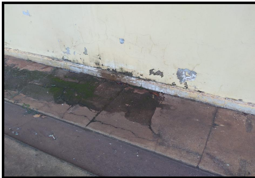
Anexo 14: Bolo no piso externo da ala oeste do bloco pedagógico I
