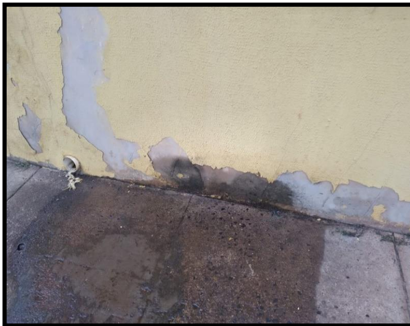
Figura 23: Manchas de mofo e fungos na varanda da ala oeste do bloco administrativo
