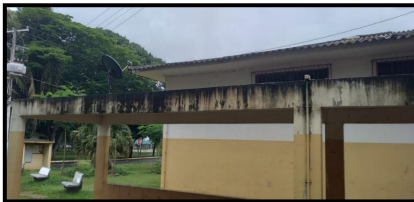
Figura 31: Manchas de mofo e fungos na passarela da ala sul do bloco administrativo
