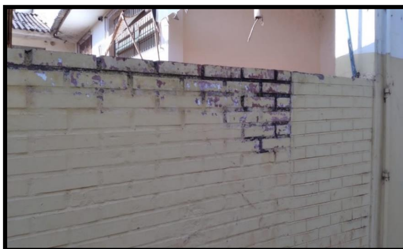
Figura 24: Manchas de mofo e fungos na varanda da ala oeste do bloco administrativo
