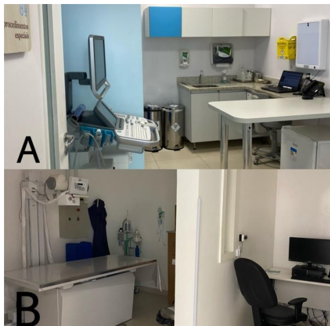
FIGURA 5 – (A) Sala de ultrassonografia, (B) Sala de radiografia, com paredes, piso, teto, visor e portas baritadas. Abril de 2022. Fonte: arquivo pessoal, 2022.
