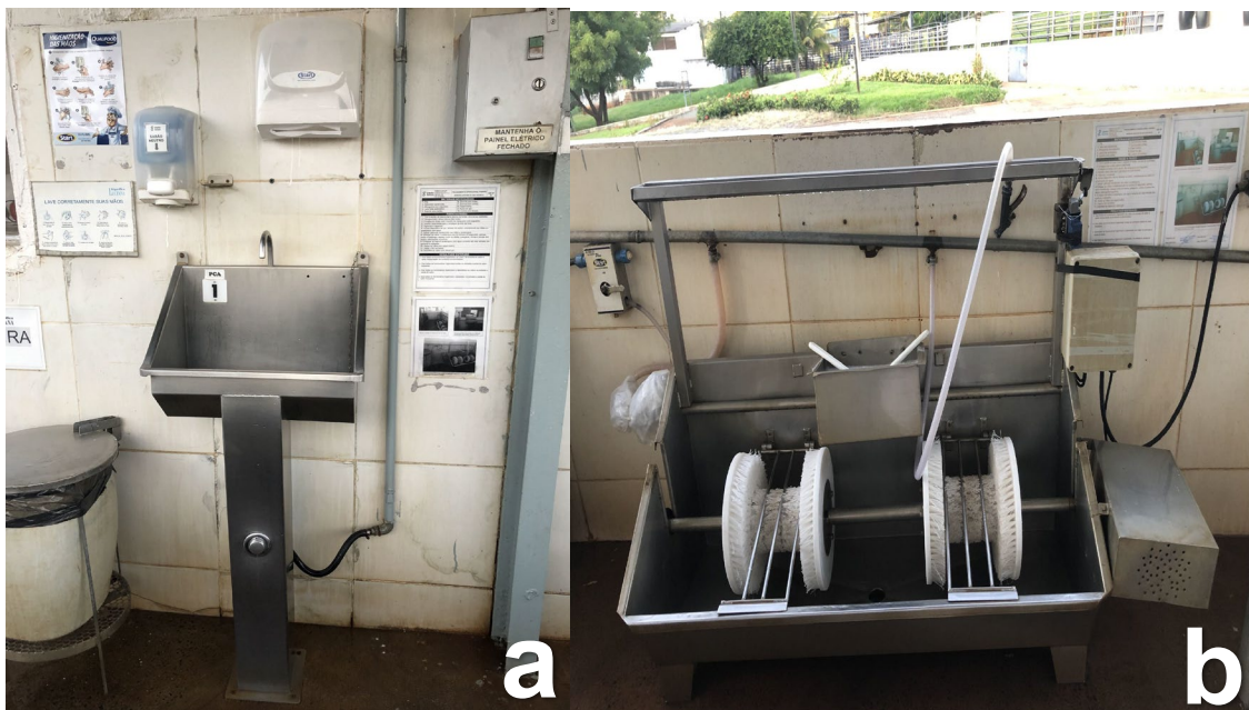
Figura 4 – Barreira Sanitária na Entrada da Sala de Abate. A) Pia para lavagem de mãos. B) Lava botas.
