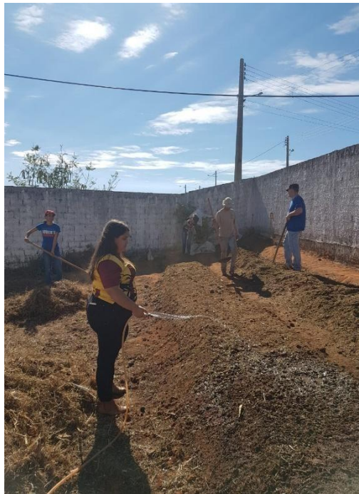
Figura 1. Alunos do curso de Engenharia Agrícola do IF Goiano – Campus Urutaí, realizando a confecção dos canteiros para restauração da horta escolar do projeto de extensão: “Irrigação automática e econômica em uma horta escolar no município de Urutaí – GO”. Autoria própria (2019).
