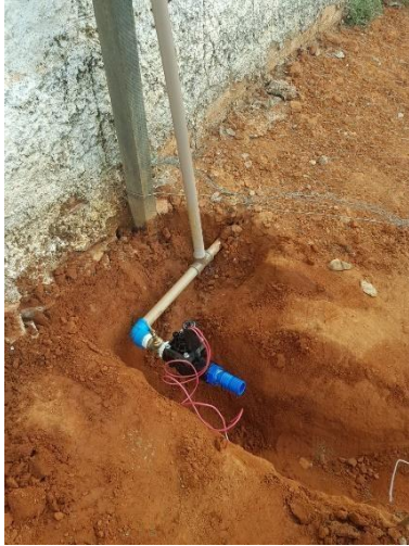
Figura 7. Válvula solenoide utilizada para a liberação do fluxo de água do reservatório para a mangueira micro perfurada. Autoria própria (2018).
