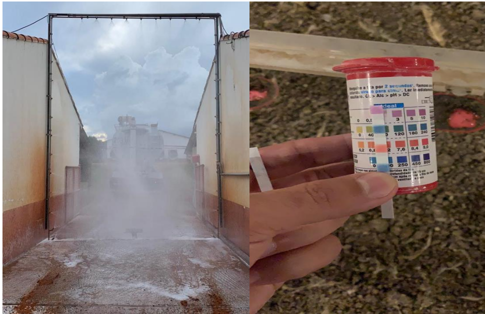
FIGURA 5 A – Arco de desinfecção em funcionamento e níveis de cloro na água.
