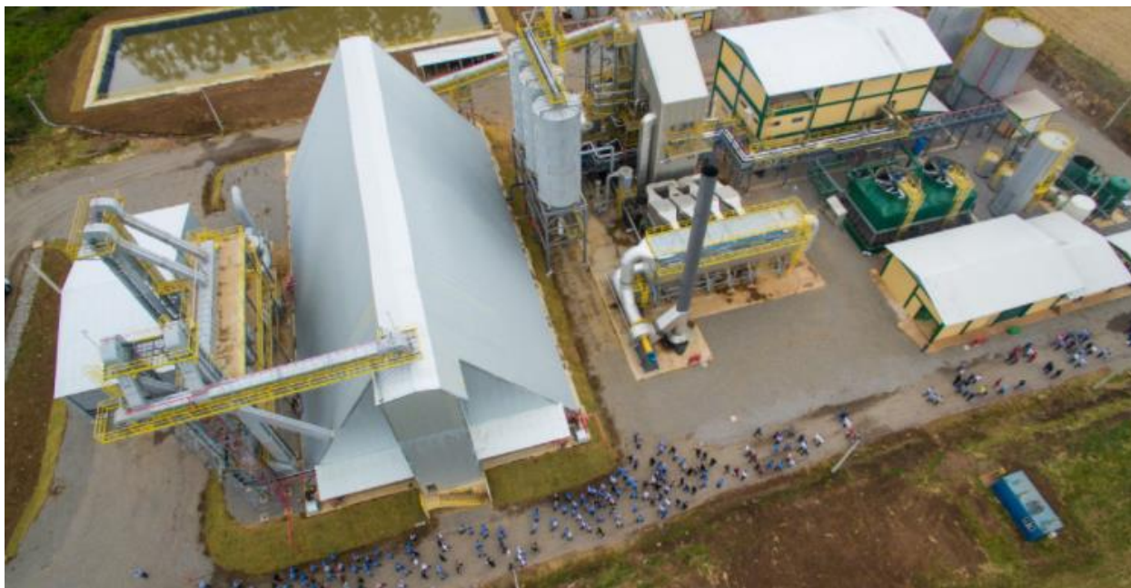
Figura 3 - Usina Termoelétrica São Sepé Fonte: https://www.saosepe.rs.gov.br/ (2021)
