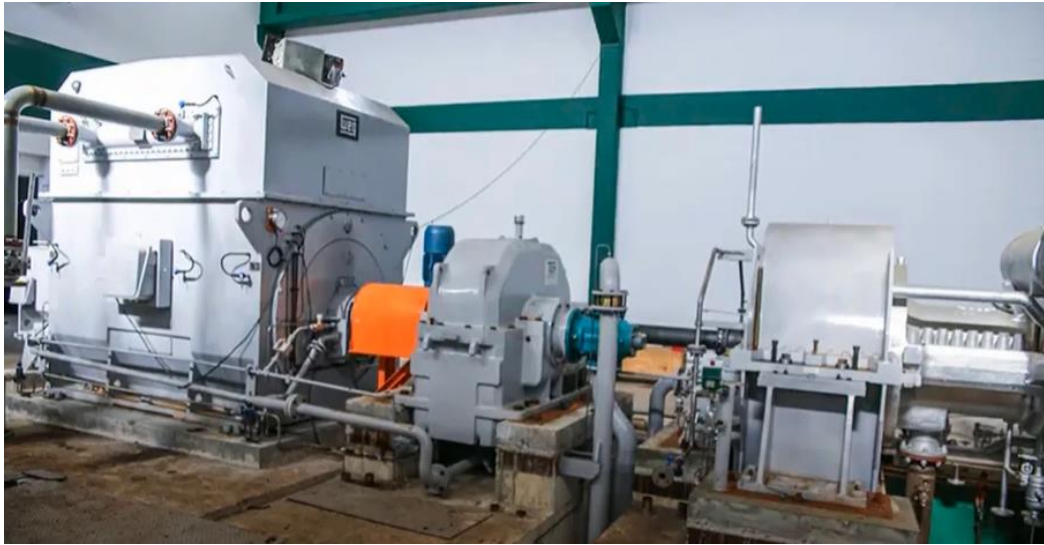
Figura 6 - Conjunto turbo gerador da UTE Fonte: UTE São Sepé (2018)
