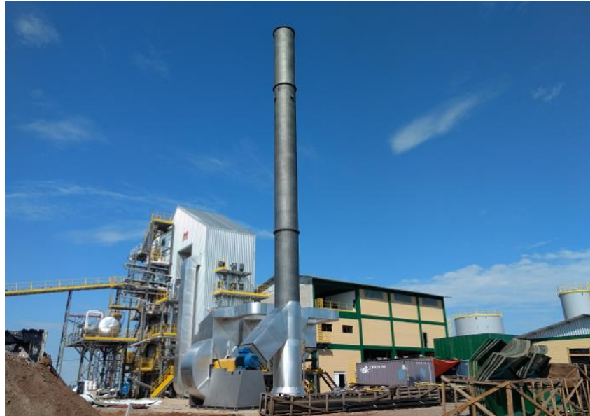
Figura 4 - Usina Termoelétrica São Sepé Fonte: UTE São Sepé (2018)
