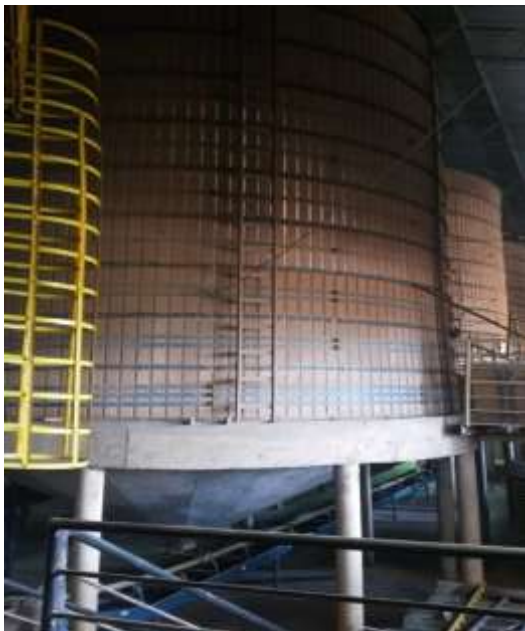
Figura 4. Silo Pulmão. Fonte: Autor
