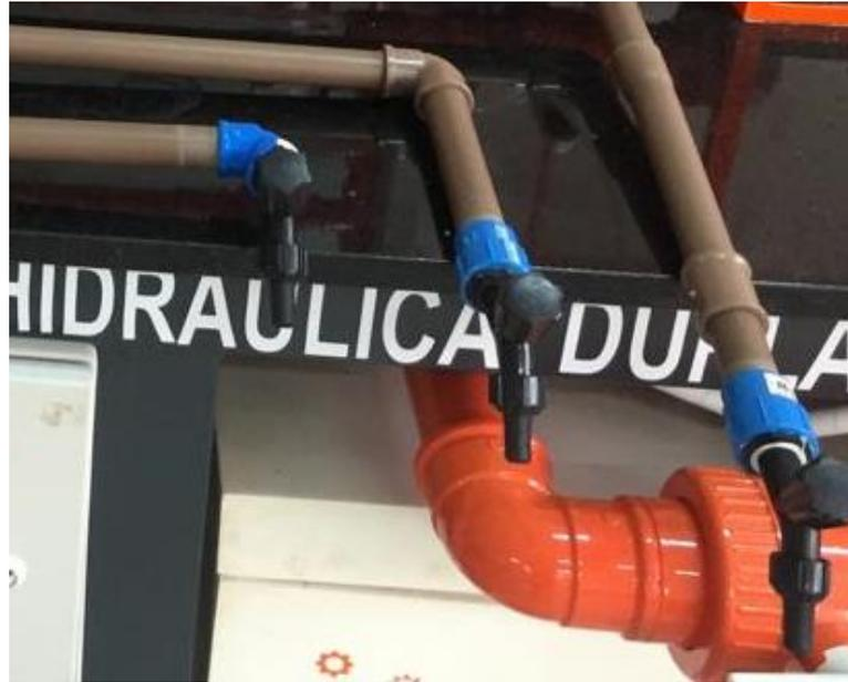
Figura 4: Torneiras de plástico utilizadas para os pontos de consumo.
