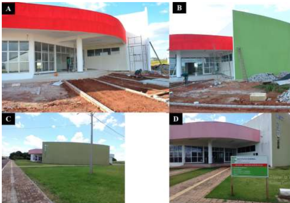
Figura 26. A e B. Biblioteca e auditório do IF Goiano – Campus Morrinhos em construção; C e D. Estrutura atual já finalizada. Fonte: arquivo pessoal e redes sociais do IF Goiano Campus – Campus Morrinhos, fotos tiradas em A. e B. 2016 e C. e D. 2022.
