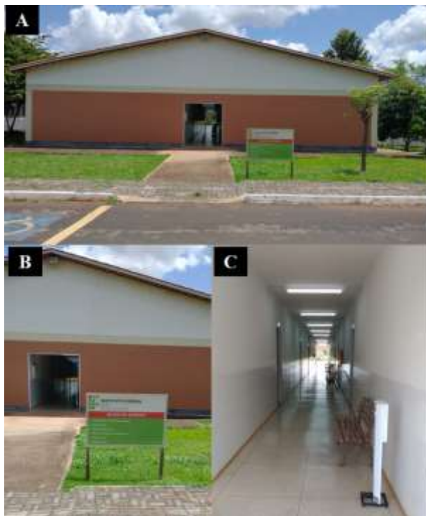
Figura 21. A e B. Bloco da química; C. Corredor com laboratórios de química e salas de aula. Fonte: arquivo pessoal, 2022.
