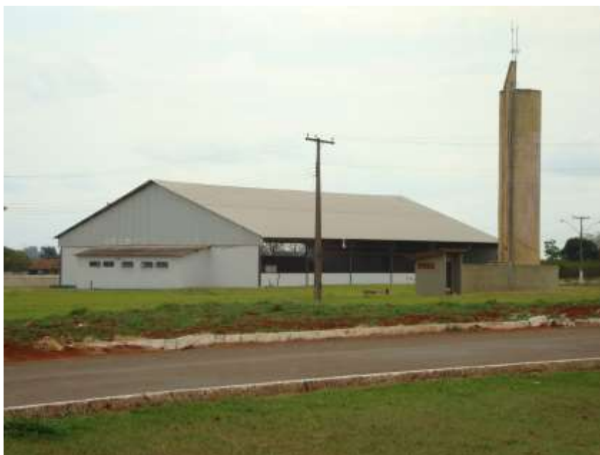
Figura 1. Foto da primeira caixa d'água feita no IF Goiano – Campus Morrinhos. Fonte: Acervo do IF Goiano – Campus Morrinhos, 2015.
