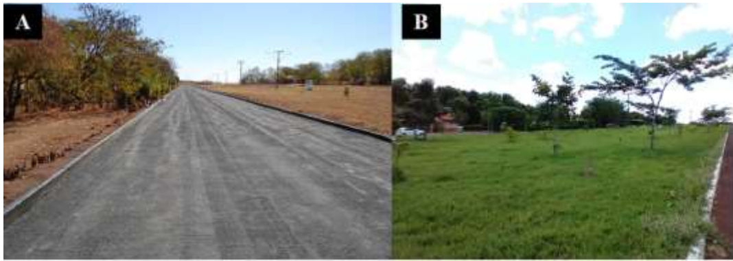
Figura 30. A. Pavimentação do asfalto no setor administrativo; B. Imagens atuais do setor administrativo. Fonte: arquivo pessoal e redes sociais do IF Goiano – Campus Morrinhos. Ano das fotos, A. 2016 e B. 2022.
