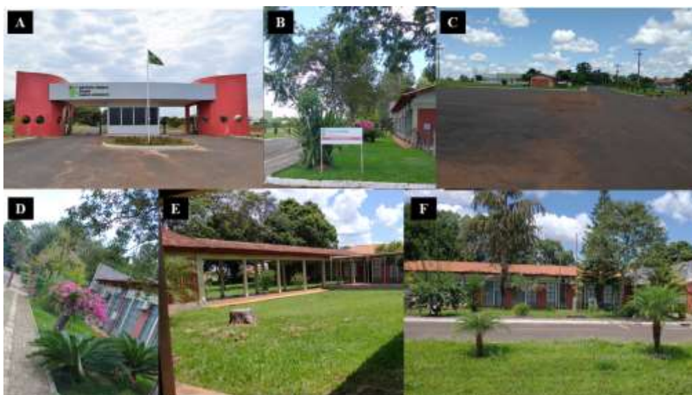
Figura 11. A. Guarita IF Goiano Campus Morrinhos; B e C. Estacionamento; D, E e F. Bloco pedagógico. Fonte: arquivo pessoal, 2022 e rede social do Instituto Federal Goiano – Campus Morrinhos, fotos tiradas em 2022.
