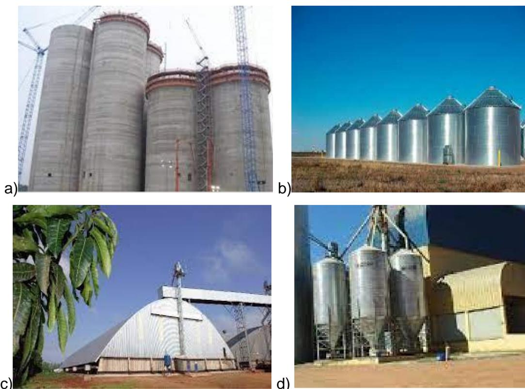
**Figura 10.** a) Silos elevados de concreto, b) Silos metálicos com fundo plano
