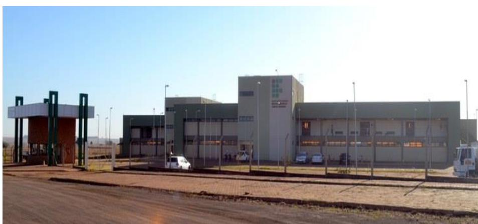
Figura 13 - Prédio do IFMS Campus Dourados
