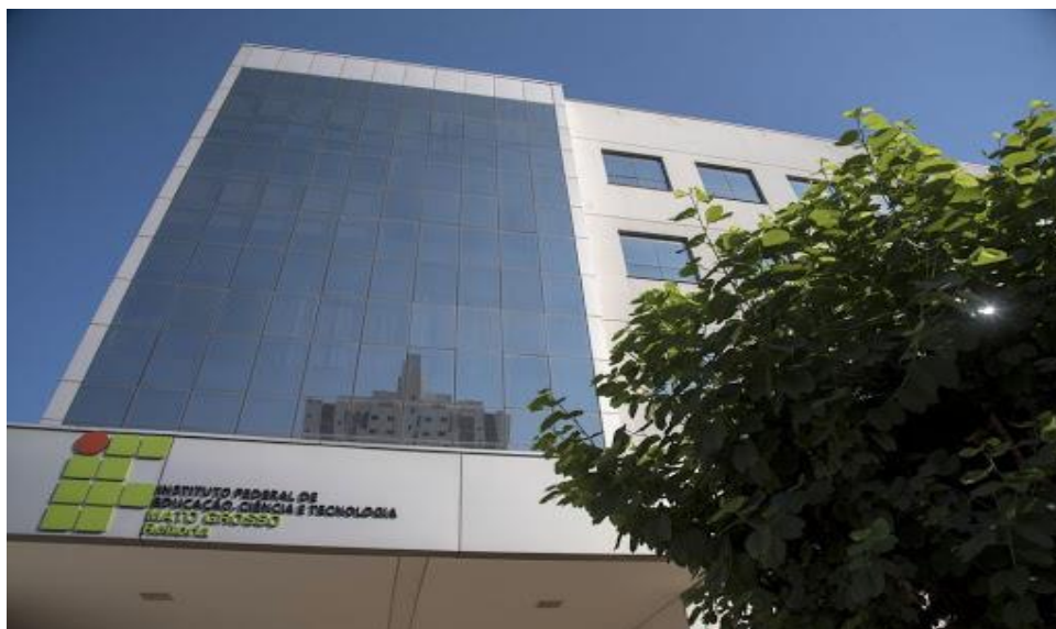
Figura 11 - Prédio da Reitoria do IFMT
