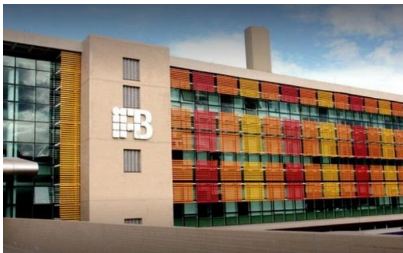
Figura 6 - Prédio do IFB Campus Brasília
