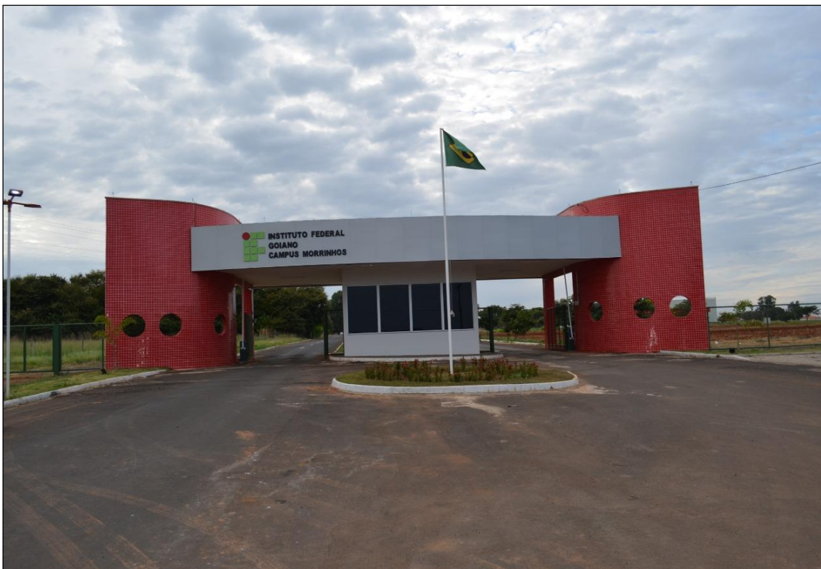
Figura 2 – Portaria de acesso ao Campus Morrinhos
