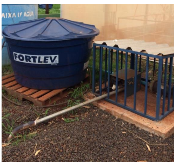
Figura 4. Bomba de ar do sistema de aquaponia.
