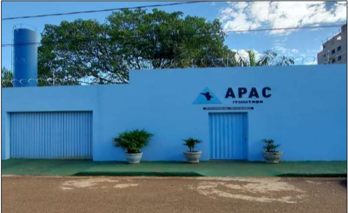
Figura 6 – Fachada da APAC de Ituiutaba/MG 2021
