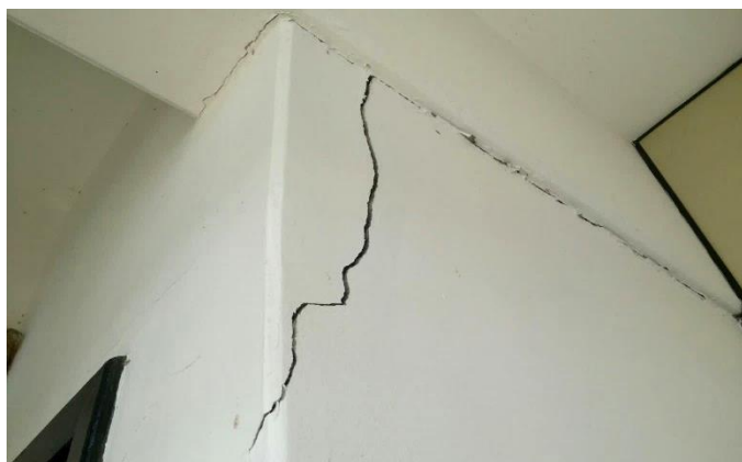
Figura 23 – Trinca causada por sobrecarga Fonte: Bahia no Ar (2016)
