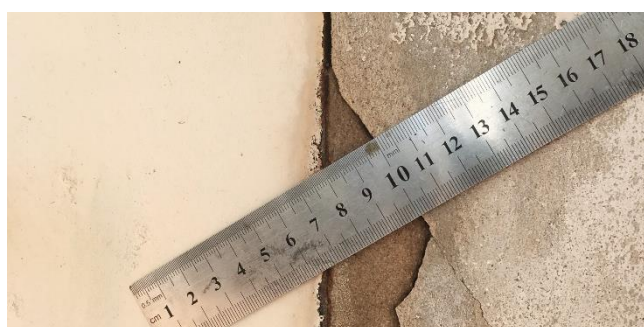
Figura 51 – Medição de abertura no reboco do pilar após 12 meses Fonte: Autor (2020)
