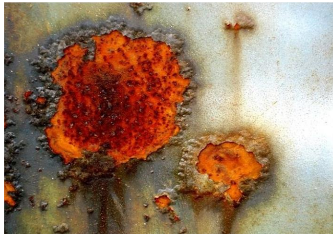
Figura 15 – Corrosão em placas na superfície metálica Fonte: Sea Lectrics Main (2012)
