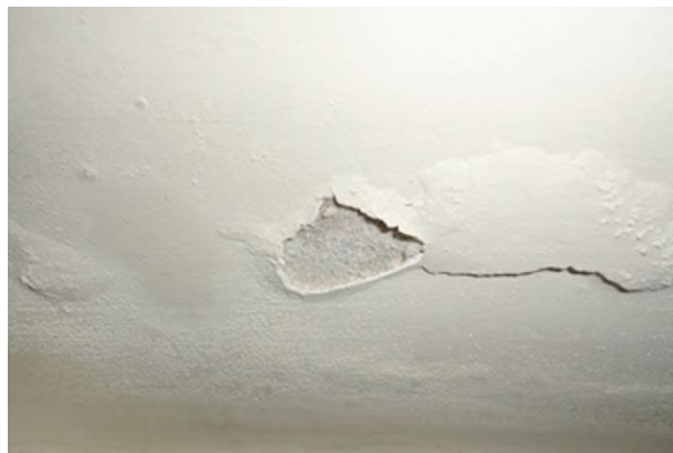
Figura 8 – Descascamento de pintura por umidade Fonte: Blogspot Impermeabilização Para Sua Casa (2013)
