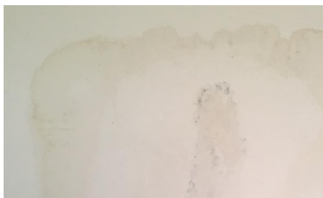
Figura 37 – Ampliação da evolução final da mancha após 12 meses Fonte: Autor (2020)
