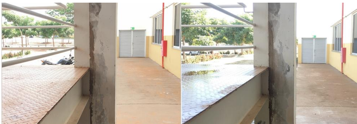
Figura 50 – Comparativo de evolução da manifestação patológica C-1 após 12 meses Fonte: Autor (2020)
