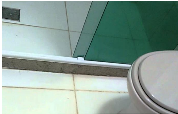
Figura 2 – Degrau em banheiro por despreparo profissional Fonte: Mundo Incrível (2015)
