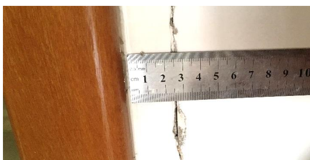
Figura 62 – Medição de abertura em alvenaria Fonte: Autor (2020)
