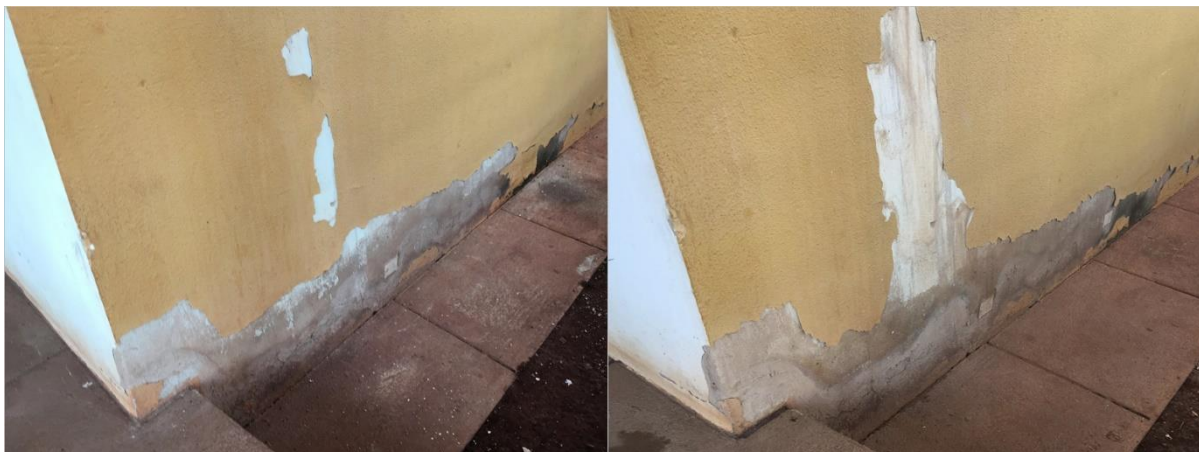
Figura 40 – Comparativo de evolução da manifestação patológica A-3 após 12 meses Fonte: Autor (2020)
