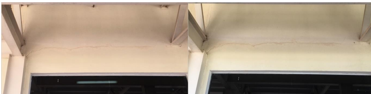
Figura 65 – Comparativo de evolução da manifestação patológica C-6 após 12 meses Fonte: Autor (2020)
