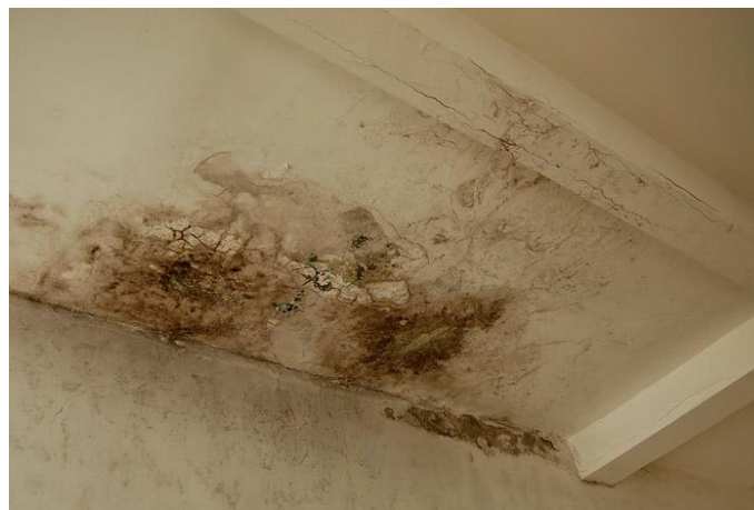
Figura 7 – Formação de bolor no teto Fonte: Leak Inspection (2018)
