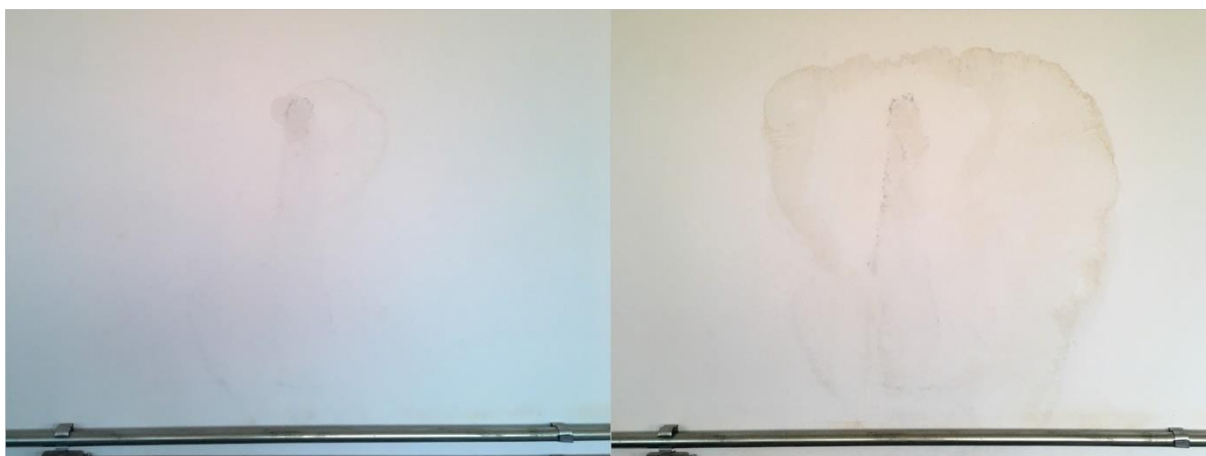
Figura 36 – Comparativo de evolução da manifestação patológica A-1 após 12 meses Fonte: Autor (2020)
