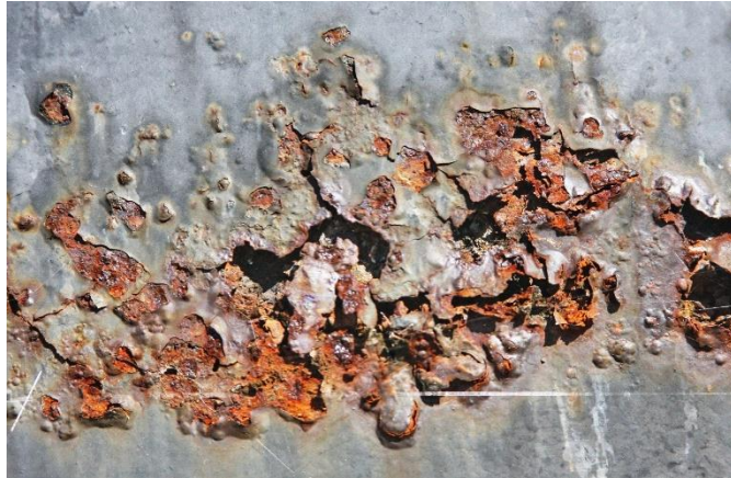
Figura 16 – Corrosão alveolar em superfície metálica Fonte: Conpleq (2016)
