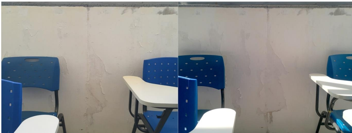
Figura 42 – Comparativo de evolução da manifestação patológica A-4 após 12 meses Fonte: Autor (2020)
