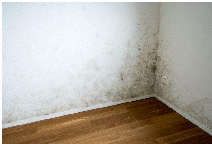
Figura 5 – Manchas ascendentes formadas na parede Fonte: Webmaster Lazzarin (2016)
