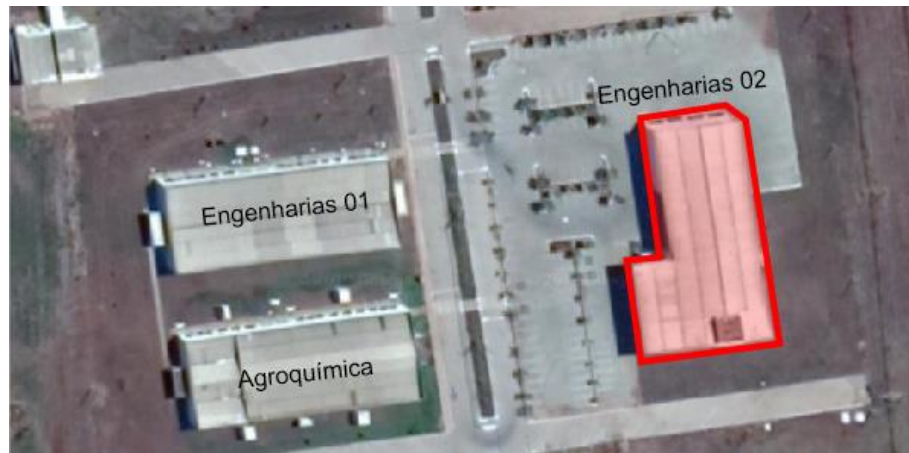
Figura 31 – Localização do bloco dentro do Campus Fonte: Google Maps (2019)
