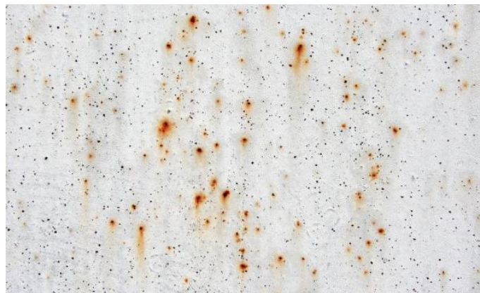
Figura 17 – Corrosão puntiforme em chapa metálica Fonte: Conpleq (2016)
