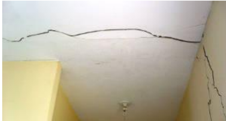
Figura 3 – Abertura em laje provocada por sobrecarga Fonte: Adaptado de Blog da Engenharia (2015)
