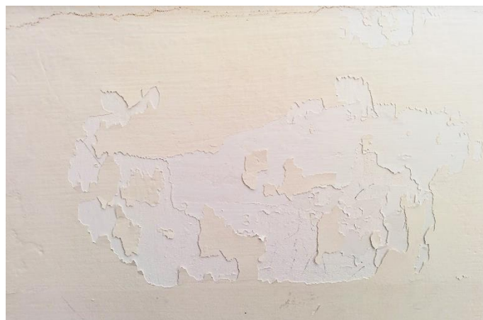
Figura 10 – Descascamento de parede por má preparação de superfície Fonte: Stack Exchange (2019)
