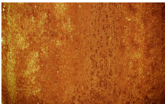
Figura 13 – Corrosão uniforme em chapa metálica Fonte: Conpleq (2016)
