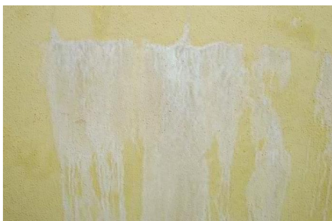
Figura 11 – Manifestação patológica de eflorescência em parede Fonte: Researchgate (2017)
