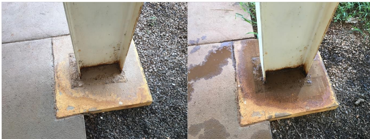
Figura 46 – Comparativo de evolução da manifestação patológica B-2 após 12 meses Fonte: Autor (2020)
