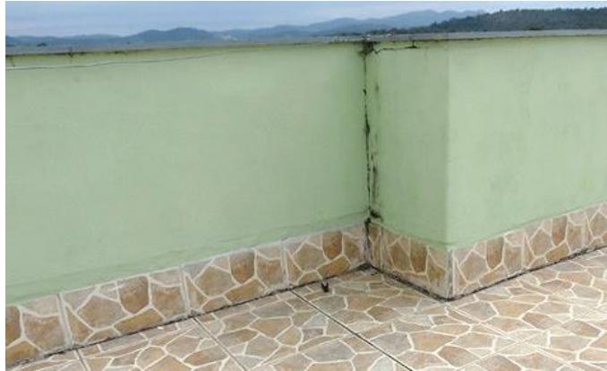
Figura 28 – Fissura horizontal causada entre alvenaria e laje Fonte: Totalize Condomínios (2016)
