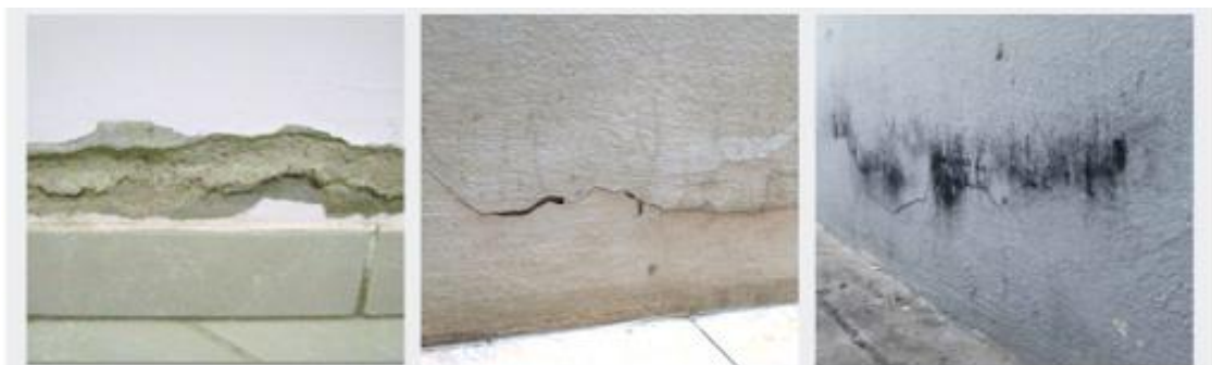
Figura 29 – Fissura horizontal causada por umidade dos elementos Fonte: GamaZ Soluções em Engenharia (2015)
