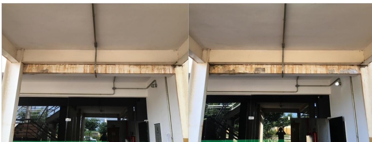
Figura 52 – Comparativo de evolução geral da manifestação patológica C-2 após 12 meses Fonte: Autor (2020)
