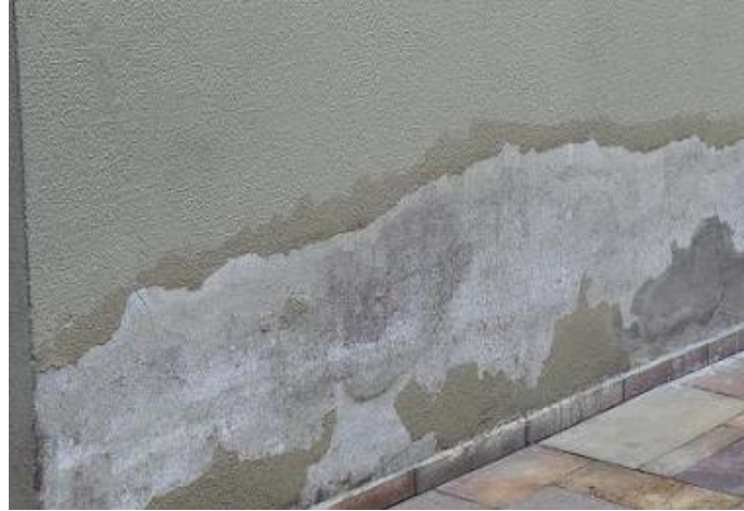
Figura 9 – Descascamento de parede externa por umidade Fonte: Construtora Cesconetto (2017)
