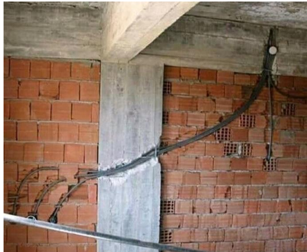
Figura 1 – Manifestação patológica devido a incompatibilidade entre projetos Fonte: Autor (2019)
