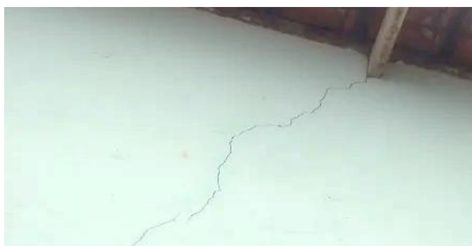
Figura 24 – Trinca sobre a parede no encontro com a terça de madeira Fonte: HabitissimoWeb (2019)
