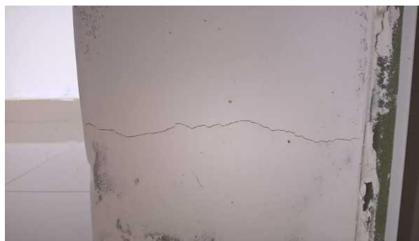
Figura 22 – Fissura horizontal causada por sobrecarga Fonte: HabitissimoWeb (2019)
