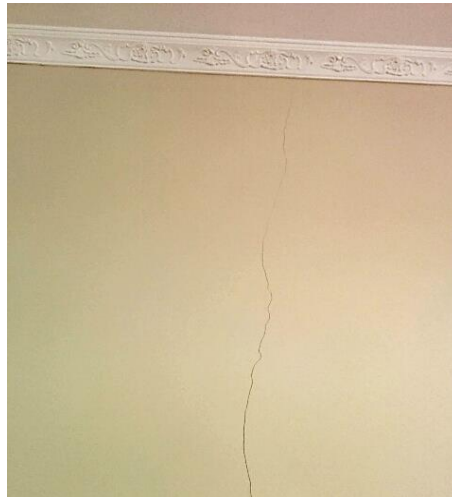
Figura 21 – Principais tipo de fissuras causadas por sobrecargas Fonte: Fórum da Casa (2014)
