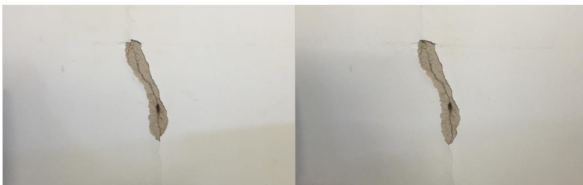
Figura 63 – Comparativo de evolução da manifestação patológica C-5 após 12 meses Fonte: Autor (2020)
