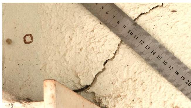
Figura 66 – Medição de abertura no topo do pilar metálico Fonte: Autor (2020)
