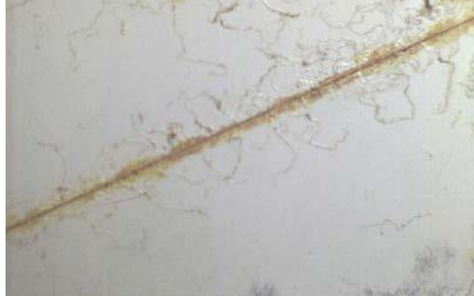
Figura 14 – Corrosão filiforme em superfície metálica Fonte: Doc Player Web (2013)
