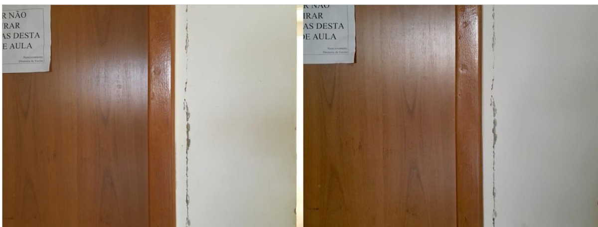
Figura 61 – Comparativo de evolução da manifestação patológica C-4 após 12 meses Fonte: Autor (2020)
