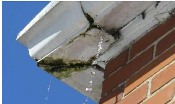
Figura 6 – Calha com problema de estanqueidade e formação de mofo Fonte: Webmaster Lazzarin (2016)
