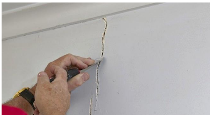
Figura 27 – Fissura vertical causada por variações de temperatura Fonte: Newsvanni Web (2018)
