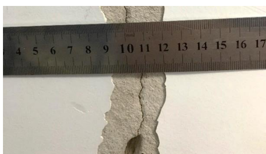
Figura 64 – Descascamento de parede externa Fonte: Autor (2020)
