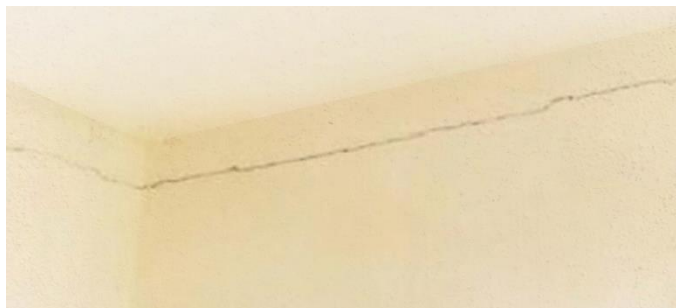
Figura 26 – Trincas horizontais em alvenaria nas proximidades da laje Fonte: Adaptado de Meu Material Wordpress (2015)
