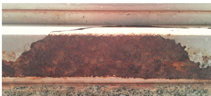
Figura 45 – Corrosão em esquadria após 12 meses Fonte: Autor (2020)
