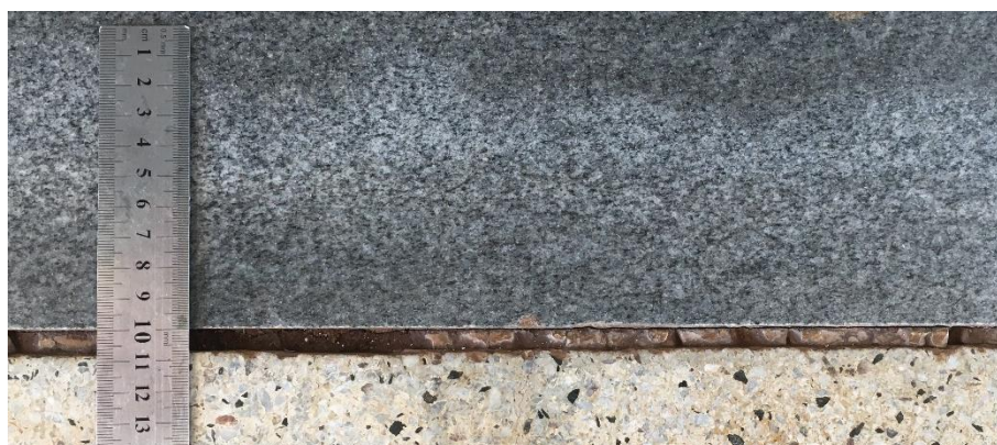
Figura 53 – Medição de abertura entre piso e soleira Fonte: Autor (2020)
