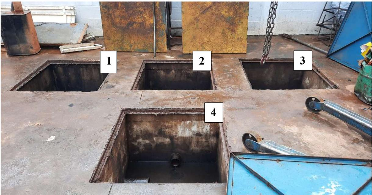
Figura 5. Sistema de Separação de Água e Óleo: 1 – Caixa de areia; 2 – caixa separadora de água e óleo; 3 – caixa coletora de óleo; 4 – caixa de inspeção.
