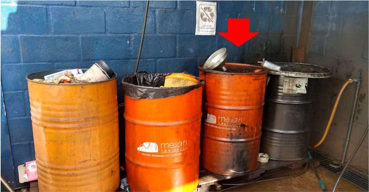
Figura 18. Armazenamento de Óleo Lubrificante Usado e Contaminado, indicado.
