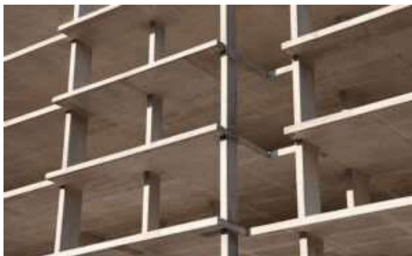
**Figura 1:** Edifício construído com lajes lisas.
