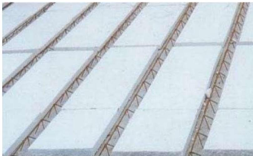
**Figura 11:** Laje treliçada em construção com EPS.
