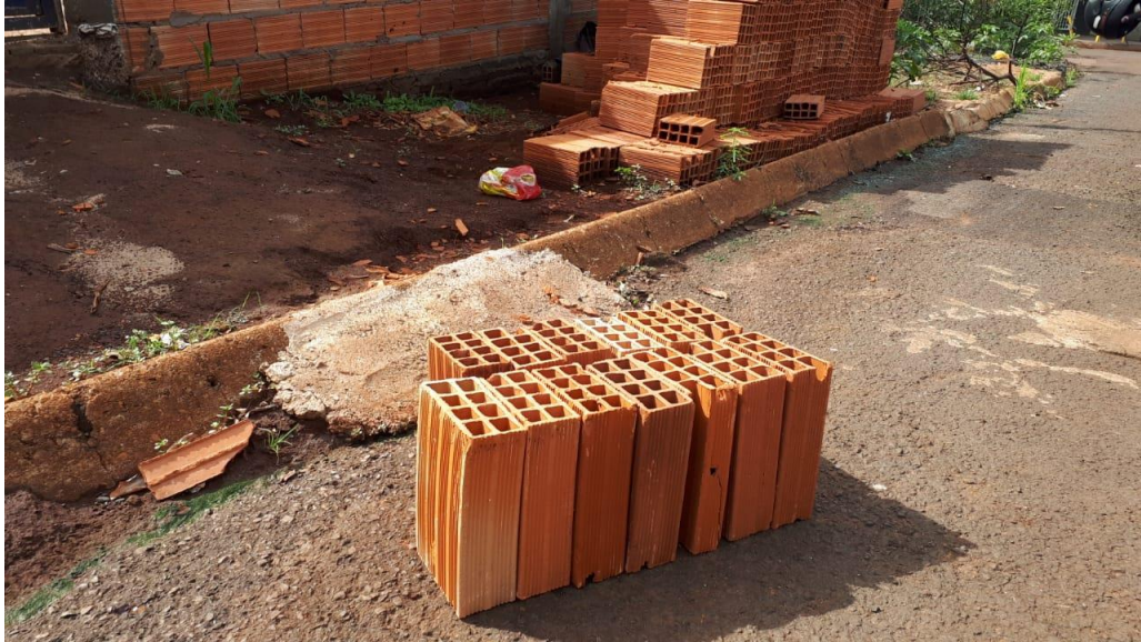
Figura 5 - Coleta de blocos cerâmicos em recepção de lote de fornecedor autônomo. Fonte: Autor, 2021.
