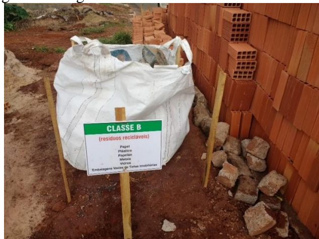
Figura 4 – Bag contendo resíduos de sacos de cimento
