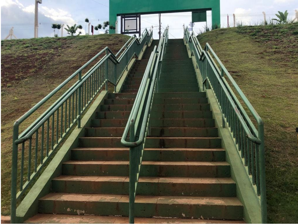
Figura 66: Guarda corpo da escada do Parque Walderes Souza de Oliveira
