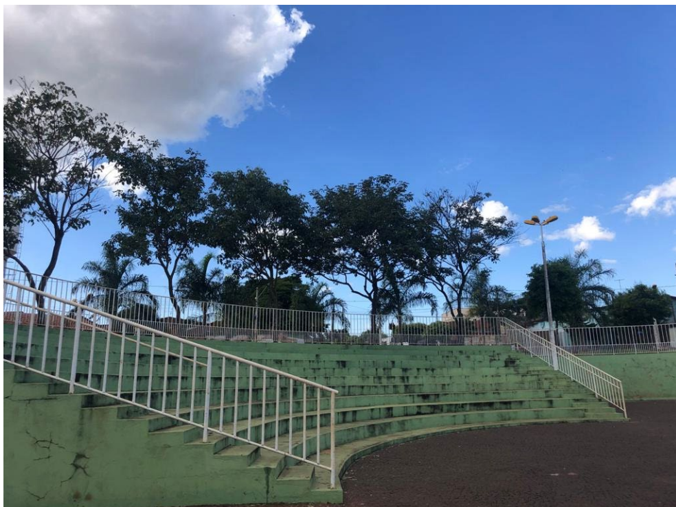
Figura 49: Guarda corpo da arquibancada da Praça João Altino Arantes
