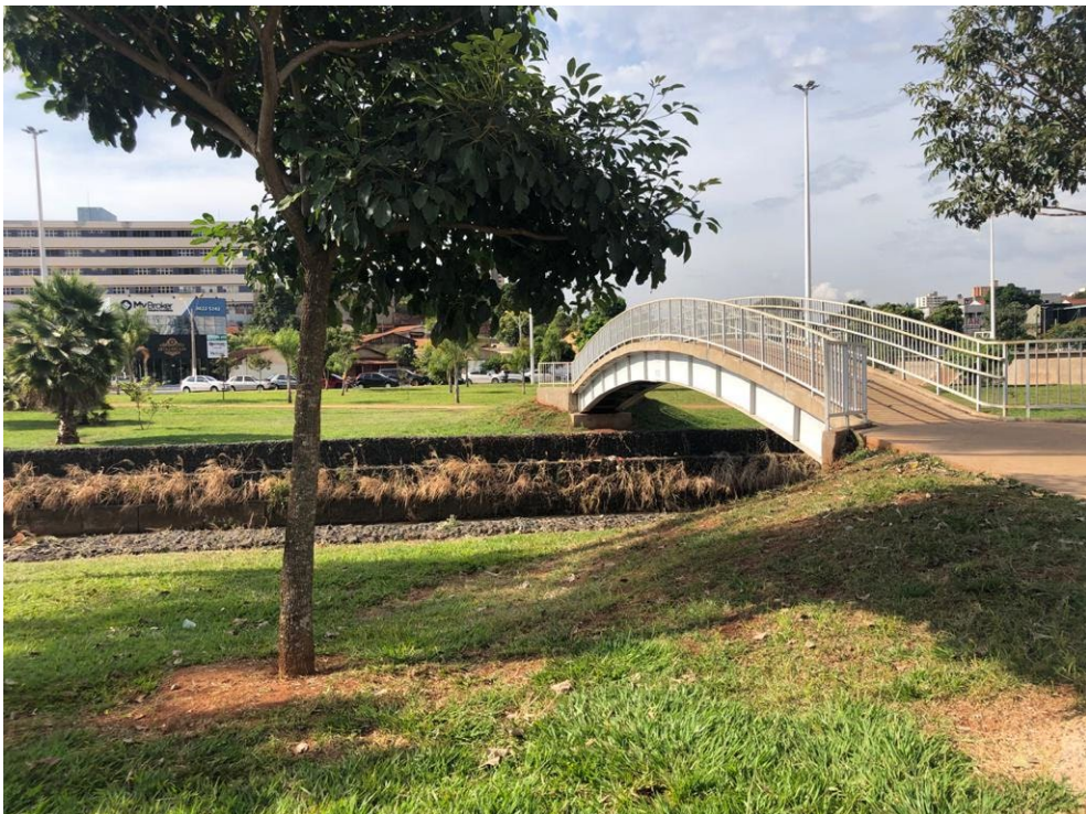
Figura 75: Guarda corpo da ponte do Parque Ecológico de Rio Verde
