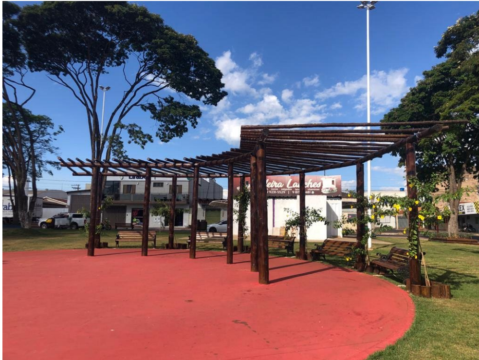
Figura 40: Pergolado da Praça Darlot Almeida
