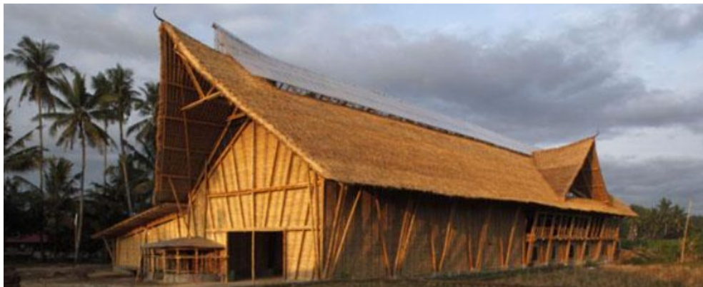
Figura 10: Exterior da Fábrica Big Tree Farms
