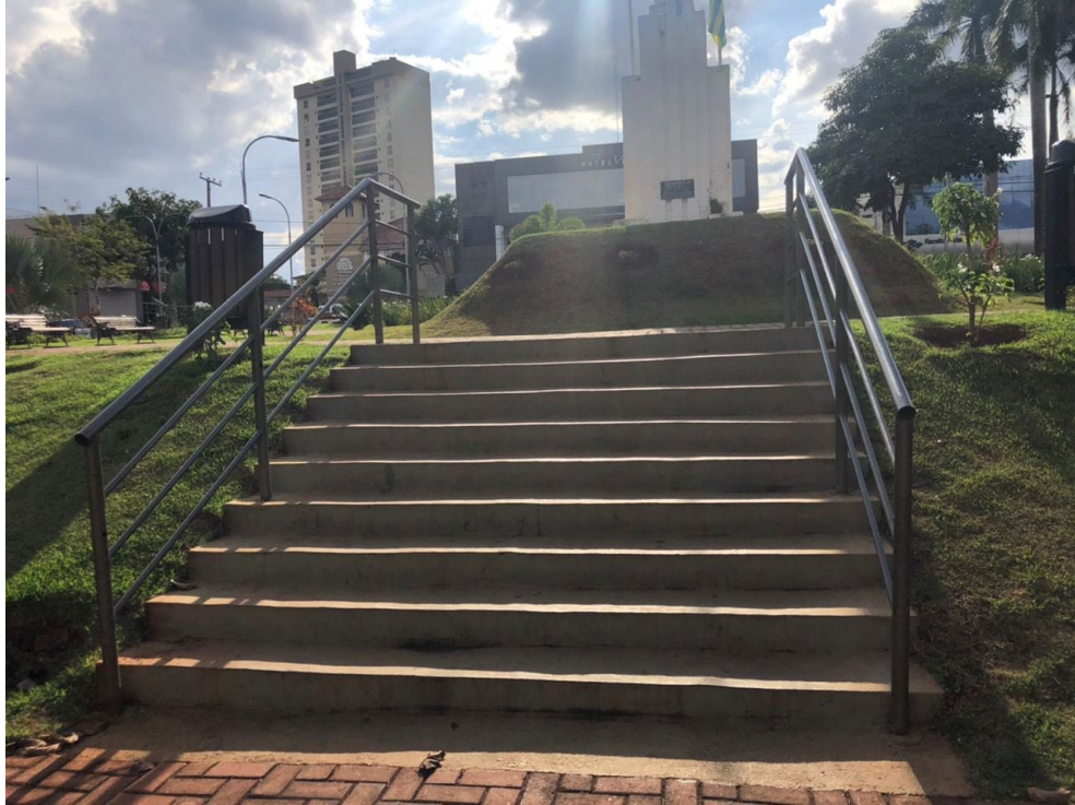
Figura 25: Corrimão da escada da Praça 5 de Agosto
