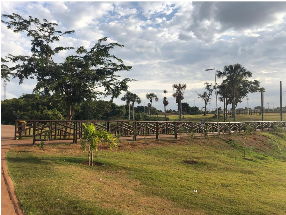
Figura 61: Guarda corpo da ponte do Parque Zilda Arns
