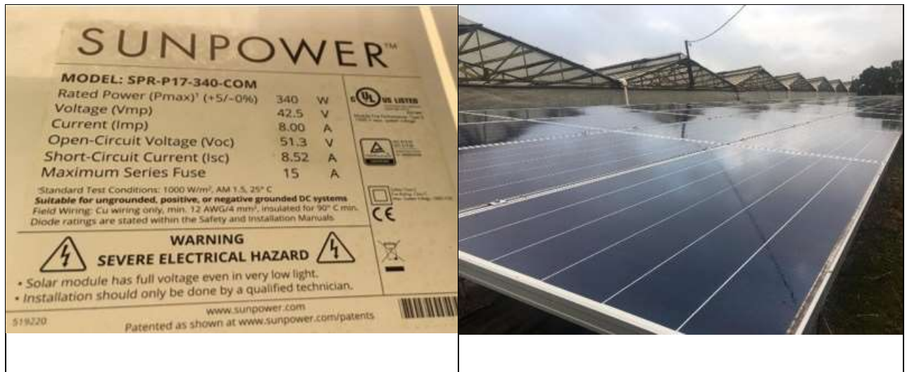
Figura 22- Características do painel fotovoltaico do sistema real existente em Kamuela – HI
