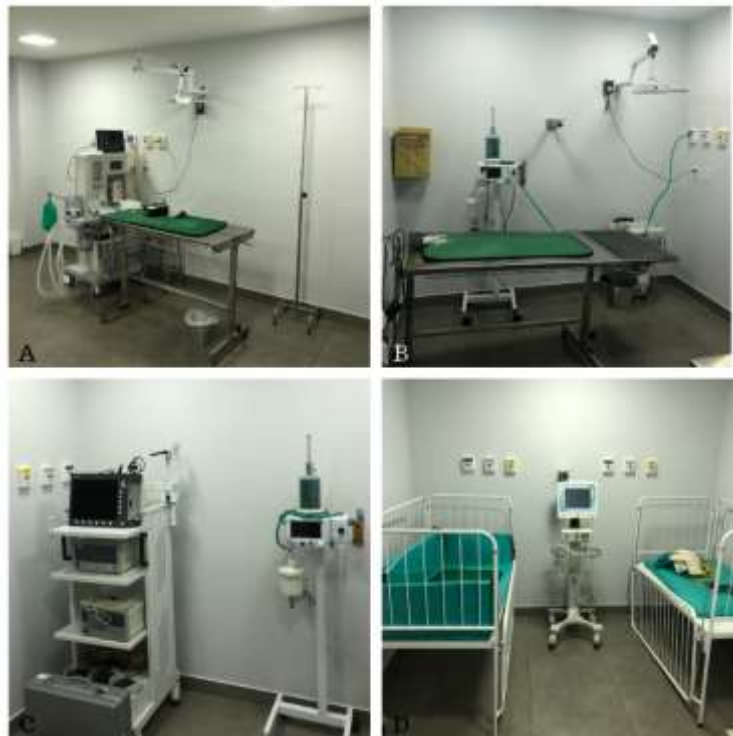
Figura 8 - Estrutura Física do Bloco Cirúrgico do Centro de Especialidades e Internação Veterinário. A) Centro cirúrgico 1. B) Centro cirúrgico 2. C) Centro cirúrgico 3. D) Unidade de terapia intensiva.
