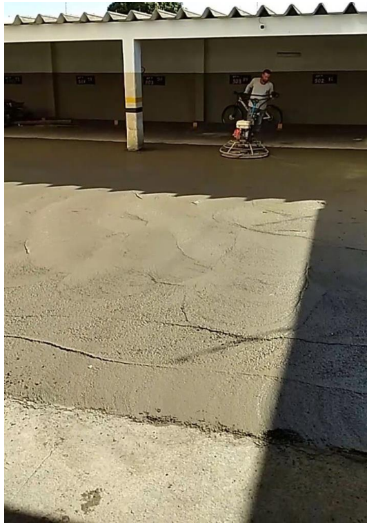
Figura 13: Execução do novo contrapiso Fonte: Próprio autor
