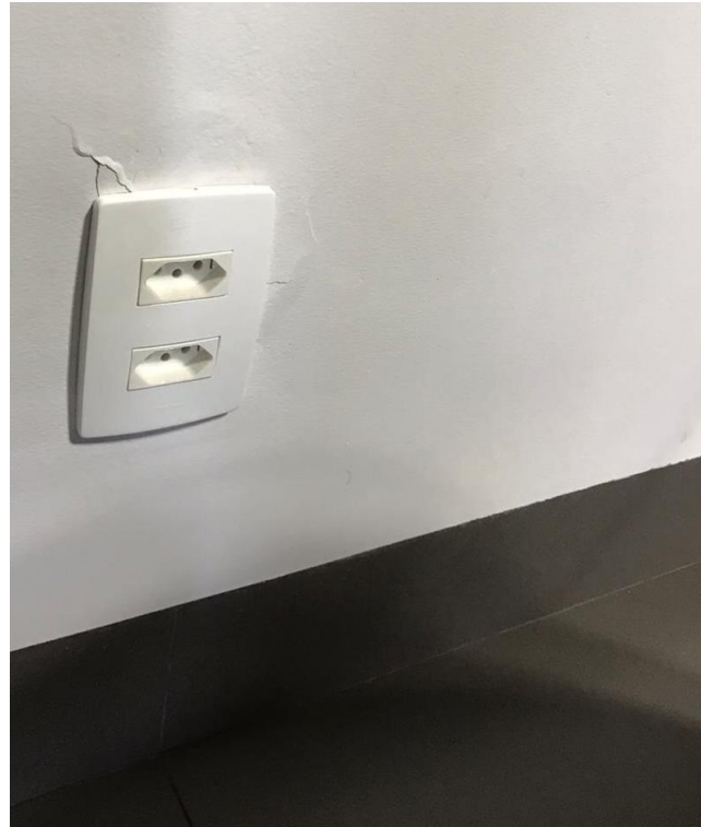
Figura 10: Manifestações patológicas devido à má impermeabilização da viga baldrame Fonte: Próprio autor
