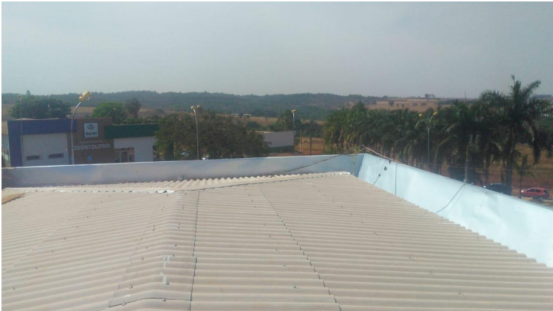
Figura 08: Execução da calha metálica Fonte: Próprio autor
