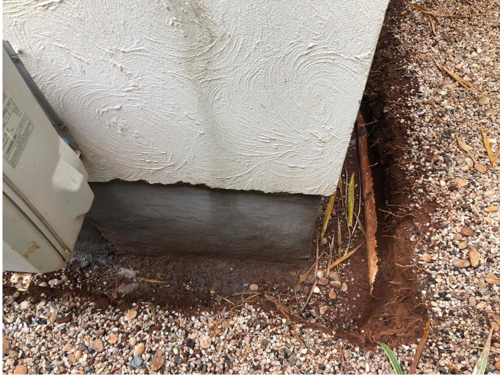
Figura 11: Retirada do solo e regularização em cima da manta Fonte: Próprio autor
