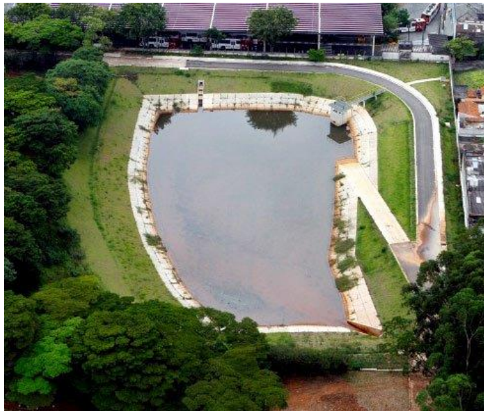
Figura 8: Reservatório de retenção Fonte: ABCP (2020)
