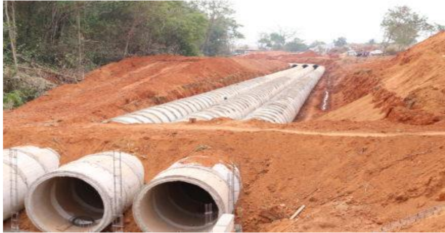
Figura 7: Galeria pluvial Fonte: Faria (2019)
