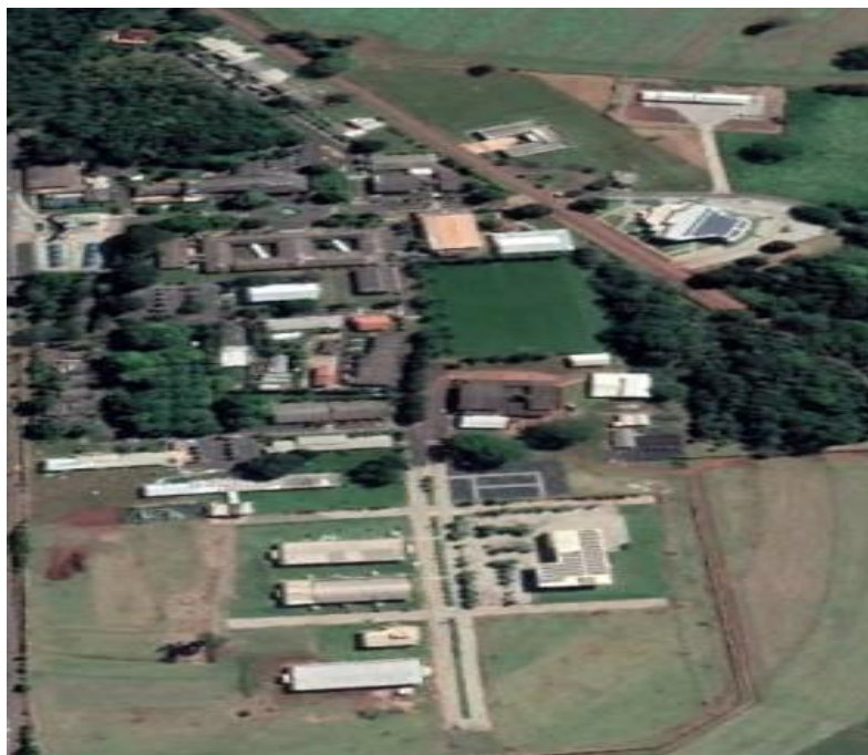
Figura 15: Estrutura do IF Goiano Campus Rio Verde em 2020 Fonte: Google Earth Pro (2020)
