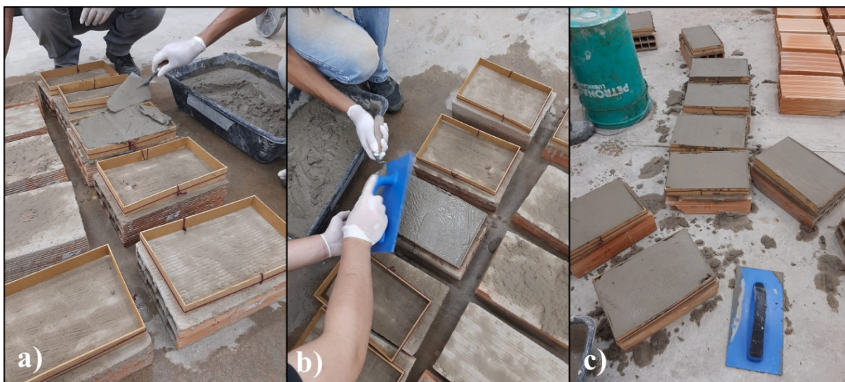
Figura 13: a) blocos umedecidos e com fôrmas recebendo a argamassa. b) desempenamento da argamassa. c) blocos finalizados. (Fonte: própria autoria).
