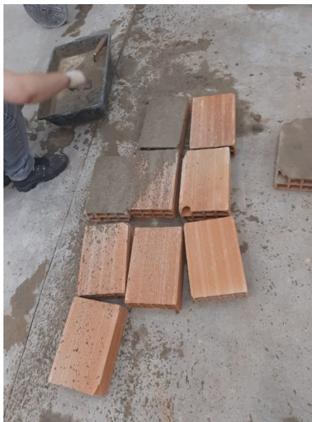
Figura 11: Aplicação do chapisco convencional. (Fonte: própria autoria).
