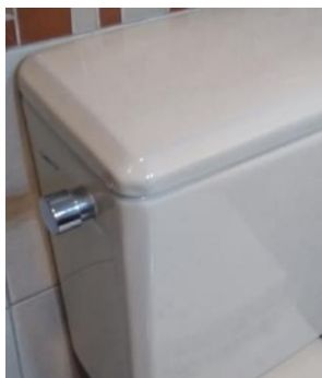
Figura 12: Sistema de descarga com acionamento único
