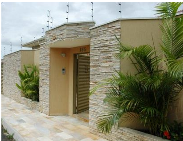
Figura 3: Vista de fachada da residência
