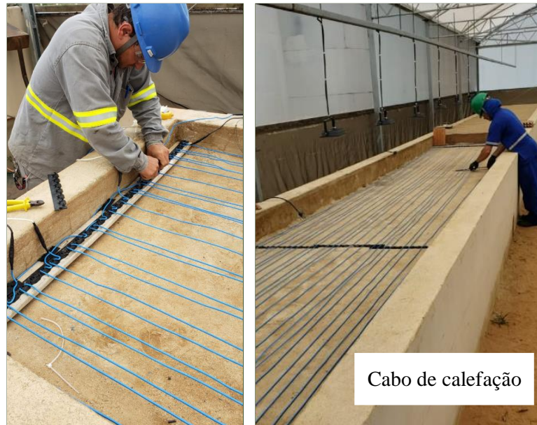
FIGURA 31 – Instalação do cabo de calefação.
