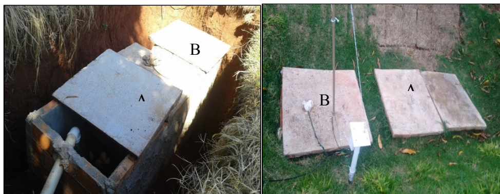
Figura 7 - Sistema existente. A - Tanque séptico; B - Tanque de reserva e bombeamento.
