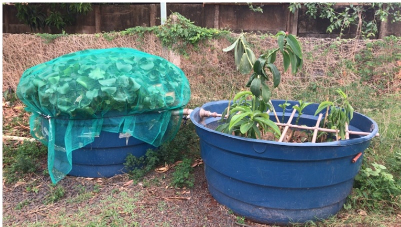
Figura 10 - Sistema alagado construído fluxo superficial de lagoa de aguapés com vegetação flutuante seguido de Sistema alagado construído subsuperficial em fluxo vertical plantado com cana-do-brejo.
