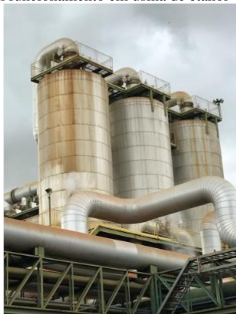
Figura 12. Evaporadores em funcionamento em usina de etanol
