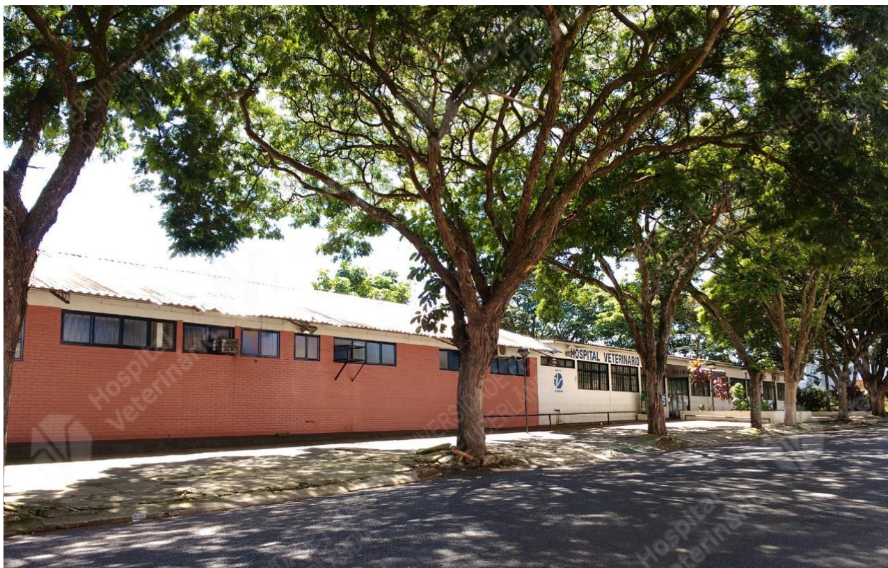
FIGURA 1 - Fachada do Hospital Veterinário – Universidade Federal de Uberlândia. Agosto de 2019.
