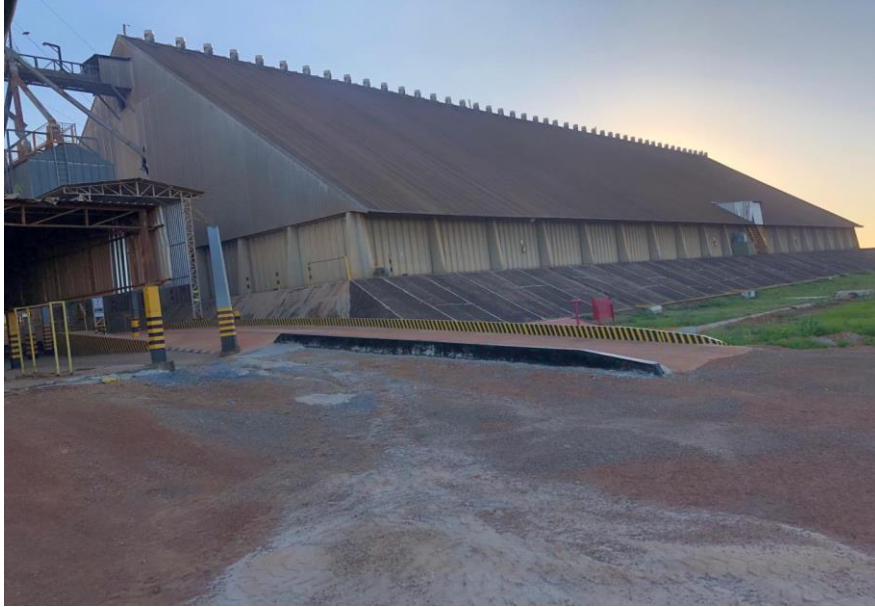
Figura 18. Armazém graneleiro fundo em "V". fonte: Souza 2023.
