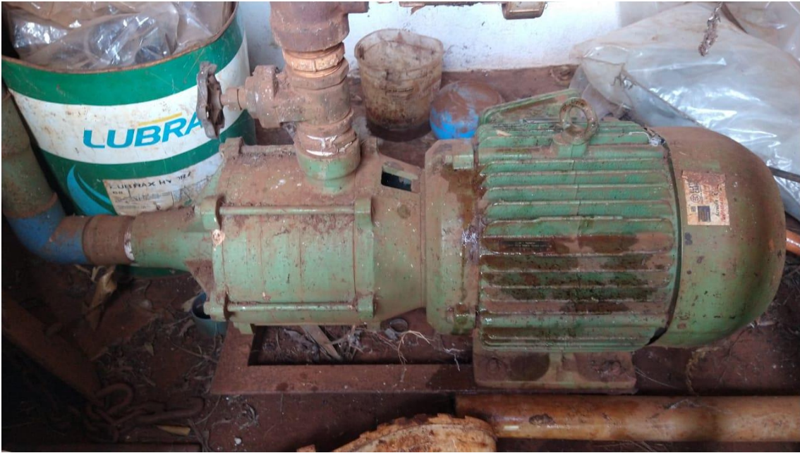
Figura 4.2. Motor Antigo de baixa eficiência e rendimento. Fonte: Autor Próprio (2024).
