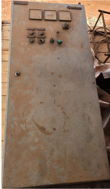
Figura 4.28. Painel para acionar a motobomba. Fonte: Autor Próprio (2024).
