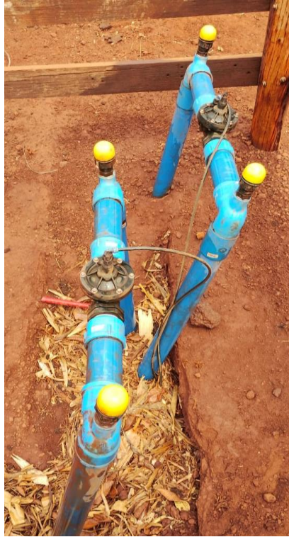
Figura 4.8. Válvulas hidráulicas. Fonte: Autor Próprio (2024).
