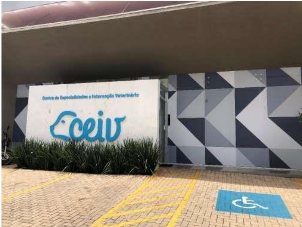
Figura 1 –Fachada do Centro de Especialidades e Internação Veterinário. Fonte: Arquivo pessoal. (2022).
