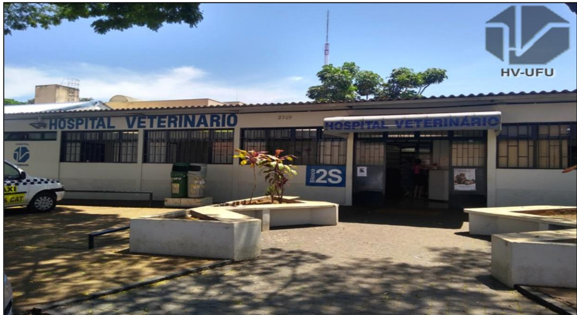
FIGURA 1 - Fachada do Hospital Veterinário da Universidade Federal de Uberlândia.
