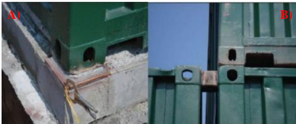
Figura 5: A) Ligação entre contêiner e fundação; B) Ligação entre contêineres Fonte: Alves et al. (2019)
