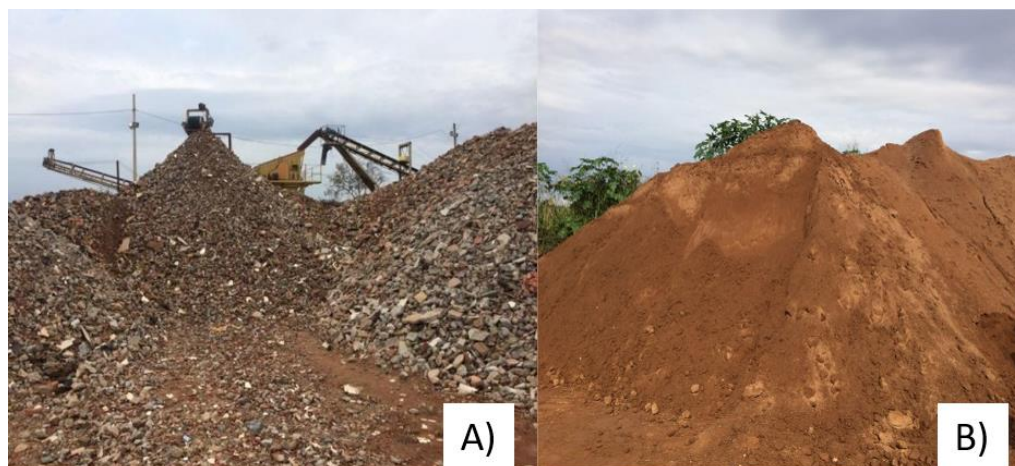
Figura 7: Resíduos (a) resíduos de construção civil após a coleta em caçambas e (b) resíduo de construção civil triturado
